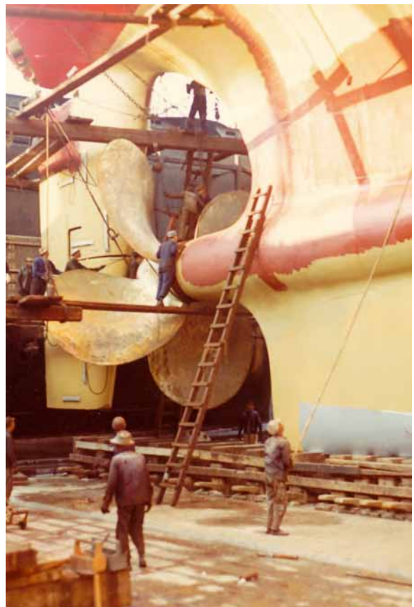
Der gøres klar til at demontere rør og skrue for trækning af skrueakslen. Foto Privat.
