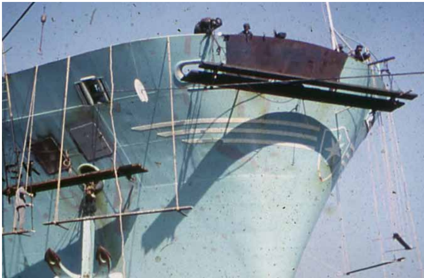
Brigantine Service udbedrer skaderne på klædningen. Arbejdsformen er typisk kinesisk, med håndkraft og stående på stillinger. Foto: Privat.
