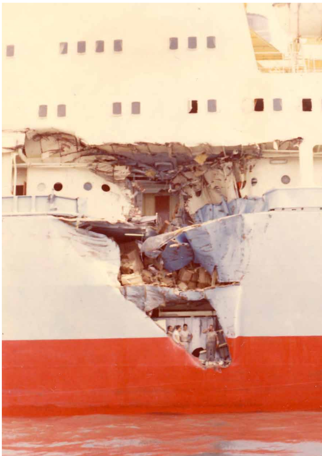
Bagbord side efter kollisionen. Hullet var direkte ind i maskinkontrolrummet. I "det store nye vindue" ses fra venstre: elektrikeren, chiefen, 1. mester og jeg selv. Foto: Privat.
